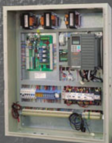
VVVF Πίνακας Inverter με απεγκλωβισμό για Μηχανικό Ανελκυστήρα
