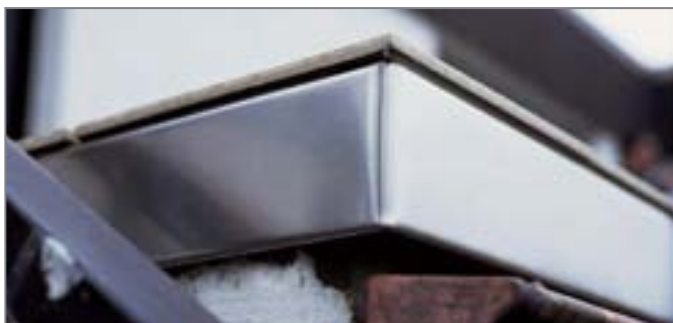
Εφαρμογή μεθόδου λεπτού στρώματος κόλλας με προφίλ πλακιδίων Balco της wedi
